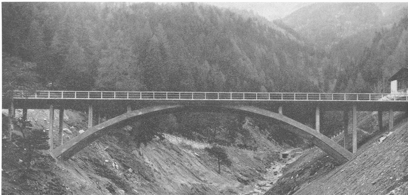
Fig. 1. — Pont de Laxgraben. Vue générale en amont.
