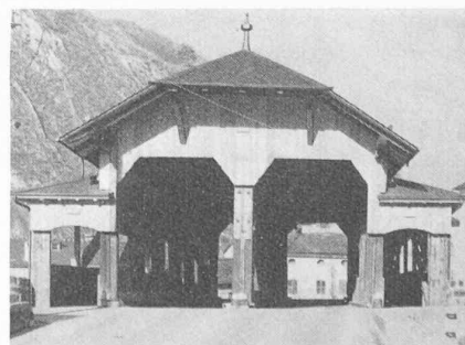
Fig. 18. — Pont de la Bâtiaz.
