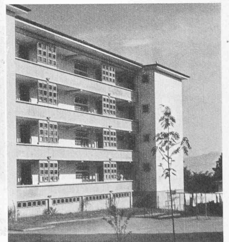
Immeuble I : les galeries d'accès
