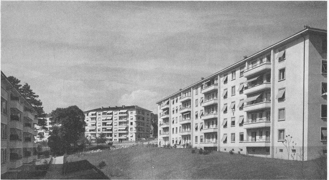
Vue d'ensemble des immeubles 1 et 2 (BERGUER & HÆMMERLI) 10 et 11 (R. ZWAHLEN)
