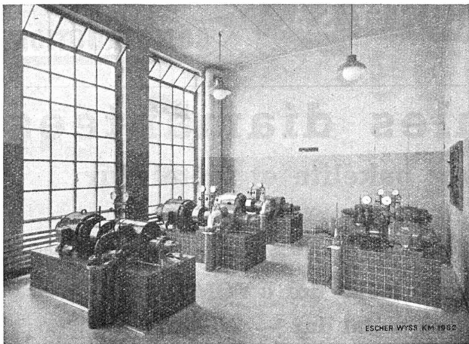
Salle des machines avec 5 compresseurs «ROTASCO» pour la réfrigération et les entrepôts frigorifiques
