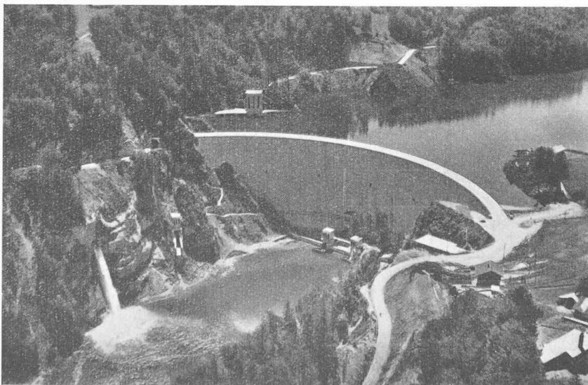
Fig. 9. — Vue générale du barrage de Rossens, prise d'avion.
