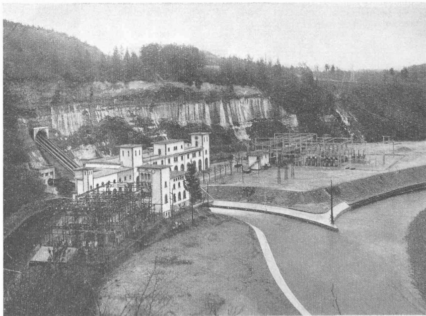
Fig. 24. — Vue générale de l'usine.
