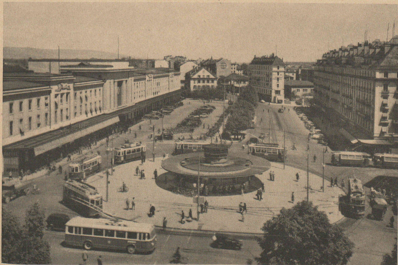
Gare CFF Genève-Cornavin. Etanchéité toitures-terrasses intérieures exécutées en asphalte souple multicouches « Système Hirschy ». Trottoirs et refuge exécutés en asphalte coulé en 1933.
