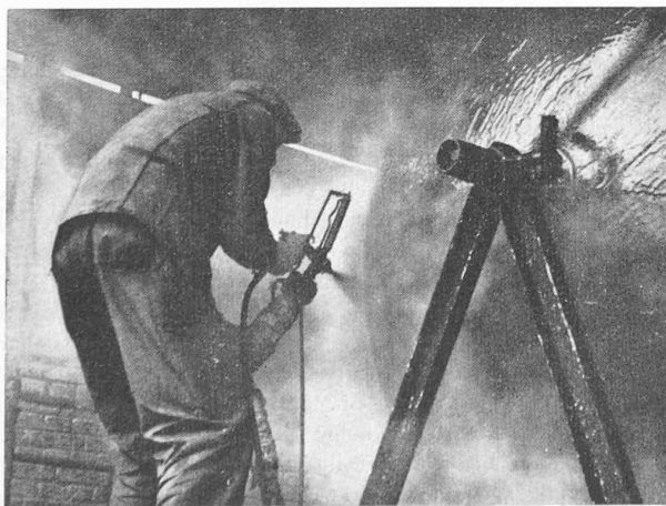
Fig. 5. — Isolation « Veroid » d'une citerne. (Meynadier & Cie, Zurich).
