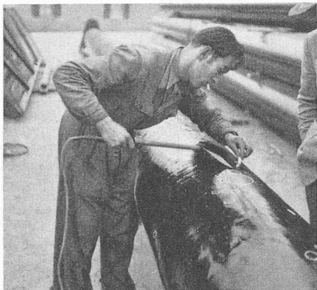
Fig. 4. — Contrôle électrique à haute tension d'une isolation « Vetro-Waberit ».
