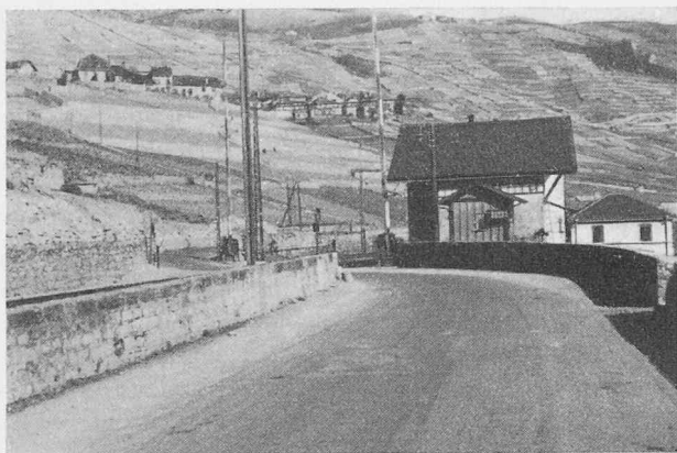
Ancien passage à niveau.
