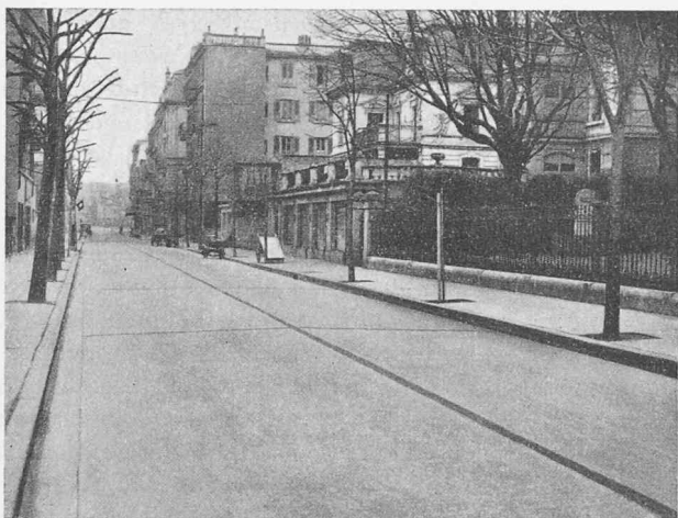
Fig. 5. — Avenue de la Gare, à Vevey. Revêtement en béton de 16 cm d'épaisseur, construit en 1931.
