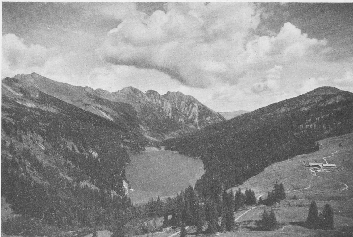
Fig. 3. — Lac d'Arnon (Berne), régularisant le cours de la Grande-Eau (Vaud).
