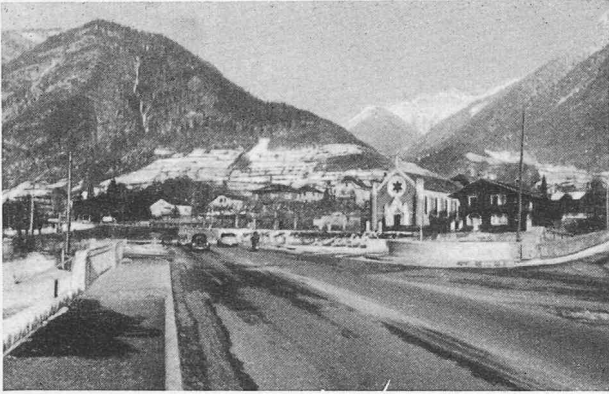
Fig. 11. — P. S. de Villeneuve. Etat de la route, construction terminée.
