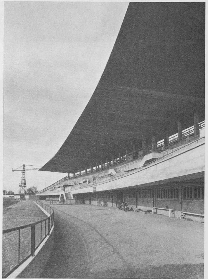
Fig. 6 et 7. — Tribune nord (photo prise des gradins est) montrant le grand porte-à-faux de la toiture et le pesage, dont le niveau est inférieur à celui du terrain de football.
