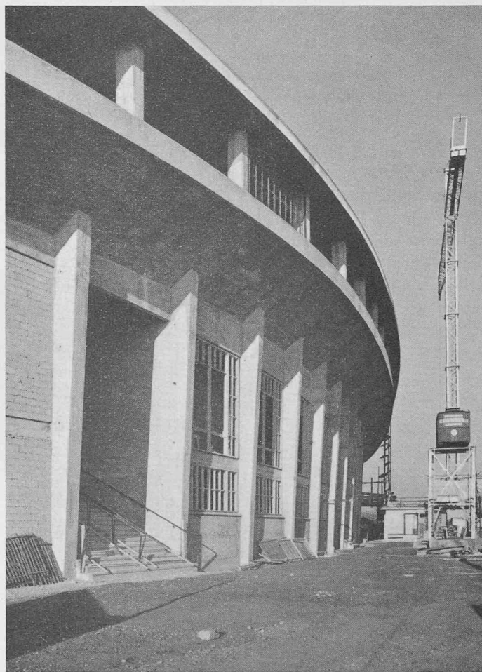
Fig. 4. — Vue partielle de la tribune nord, montrant l'un des vomitoires.
