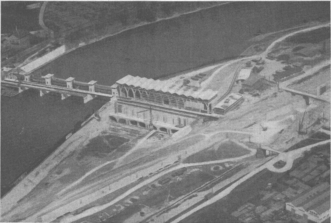
Usine hydro-électrique de Birsfelden, béton au PLASTIMENT et FRIOPLAST
