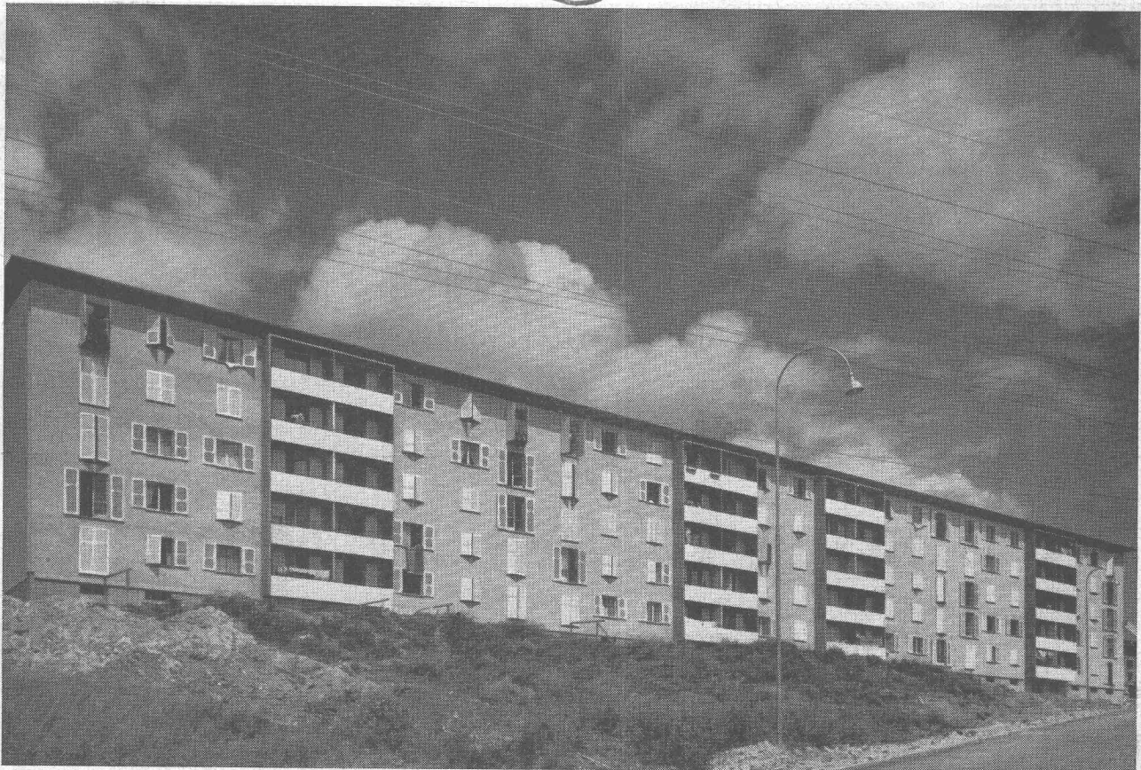
Groupe de bâtiments locatifs réalisé à la Chaux-de-Fonds par les architectes Favarger, Murisier et Studer. Les menuiseries normalisées de ces immeubles sortent de l'usine de la FABRIQUE COOPÉRATIVE DE MENUISERIE à Renens. Voir page 248 du présent numéro.
