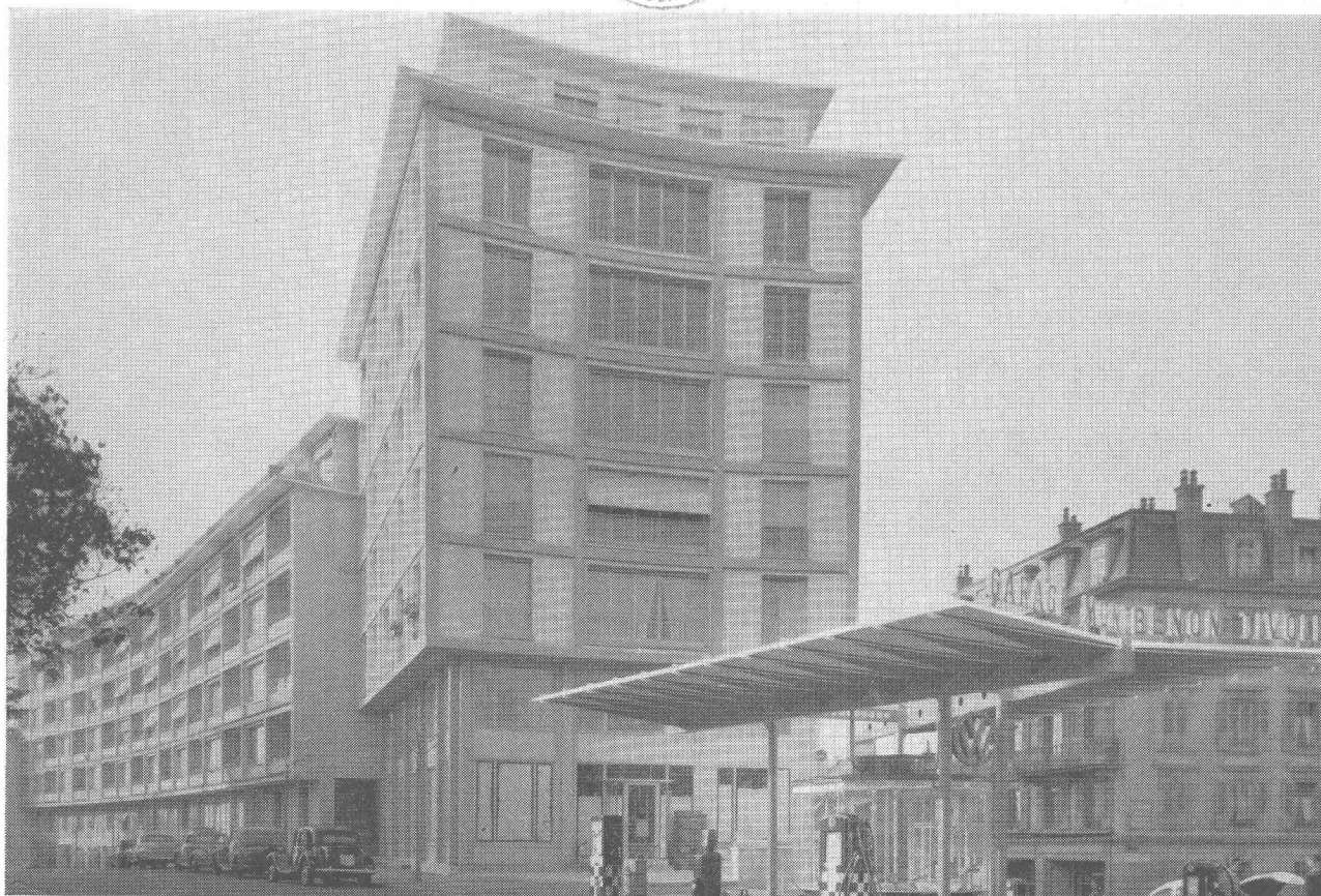
Groupe de bâtiments locatifs et commerciaux à Lausanne. — Architectes : Favarger et Murisier. Les menuiseries de ces immeubles sont l'œuvre de la Fabrique coopérative de Menuiserie de Lausanne.
