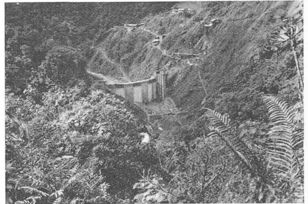
Fig. 1. — Vue générale de l'emplacement du barrage (janvier 1955).
