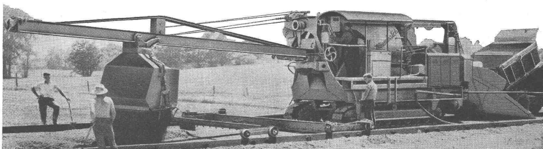
« TWINBATCH », bétonnière à tambour double sur chenilles avec distributeur de béton pivotant et roulant.
