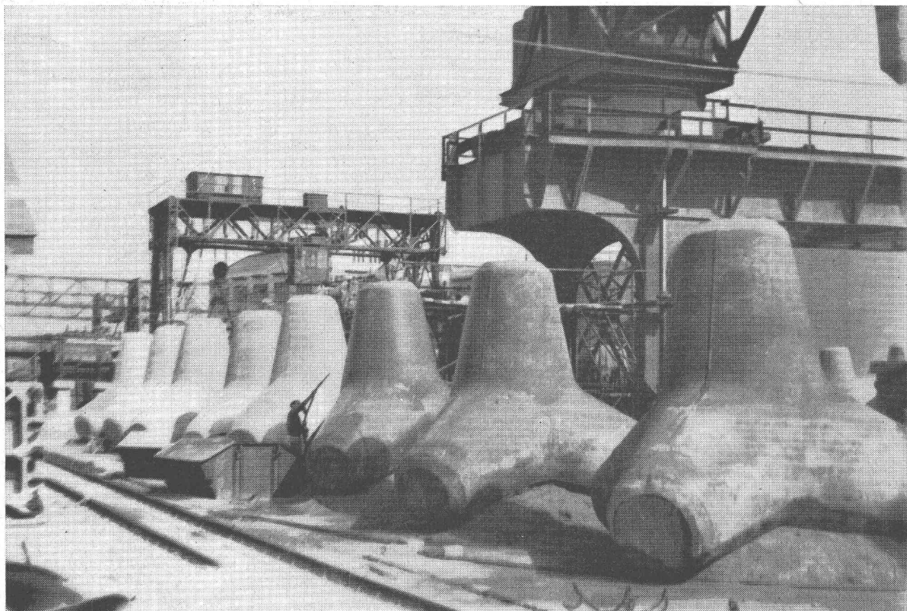
Tétrapodes système Neyrpic, béton au PLASTOCRETE
