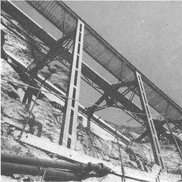
Fig. 8. — Pont 3 de Mauvoisin vu de l'aval.
