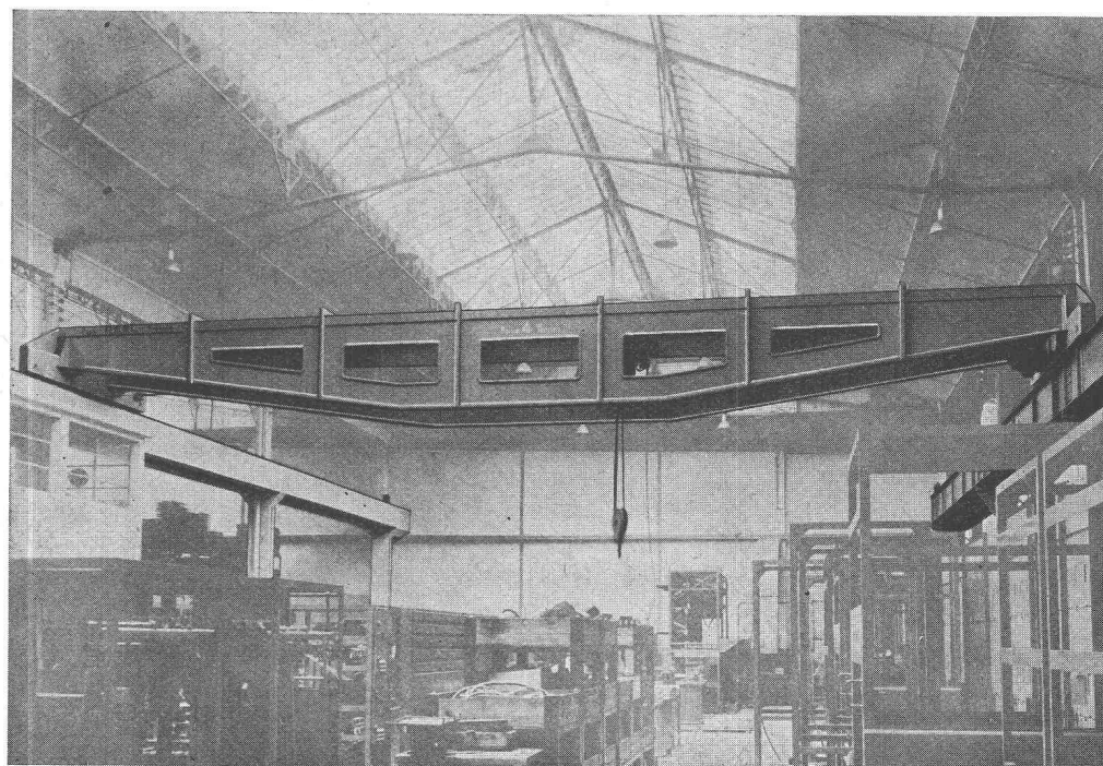
Pont roulant type RÉEL breveté (licence Ferrand & Frantz, Lyon), très esthétique. Construction exclusive pour la Suisse par
