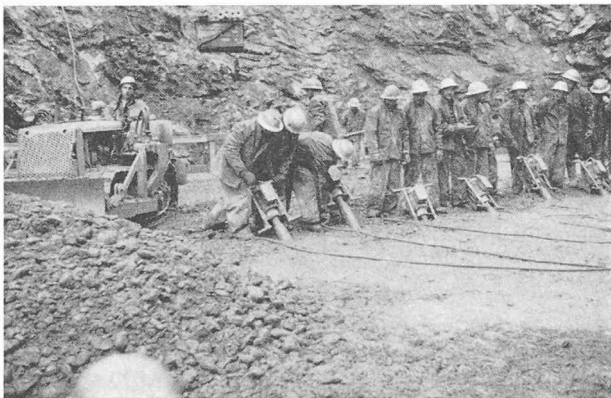
Fig. 3. — Bulldozer-épandeur en action. La pervibration est laissée « dans les mains de manœuvres ».
