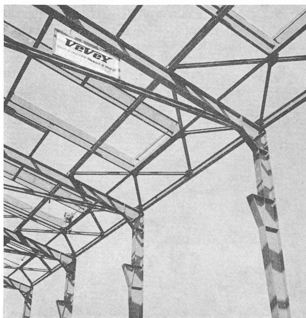
Fig. 8. — Vue d'une travée de la halle Sécheron, de 23,50 m de portée.
