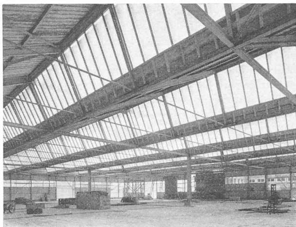
Fig. 13. — Halle de fabrication de la maison Jacot-Des Combes, à Bienne. Architectes : O. Stücker et O. Suri, Bienne.
