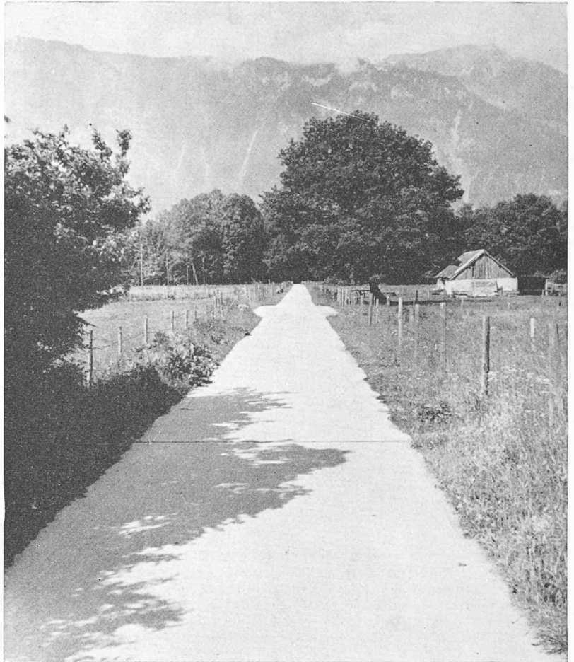
Fig. 1. — Chaussée en béton, largeur de la dalle 2,50 m.
