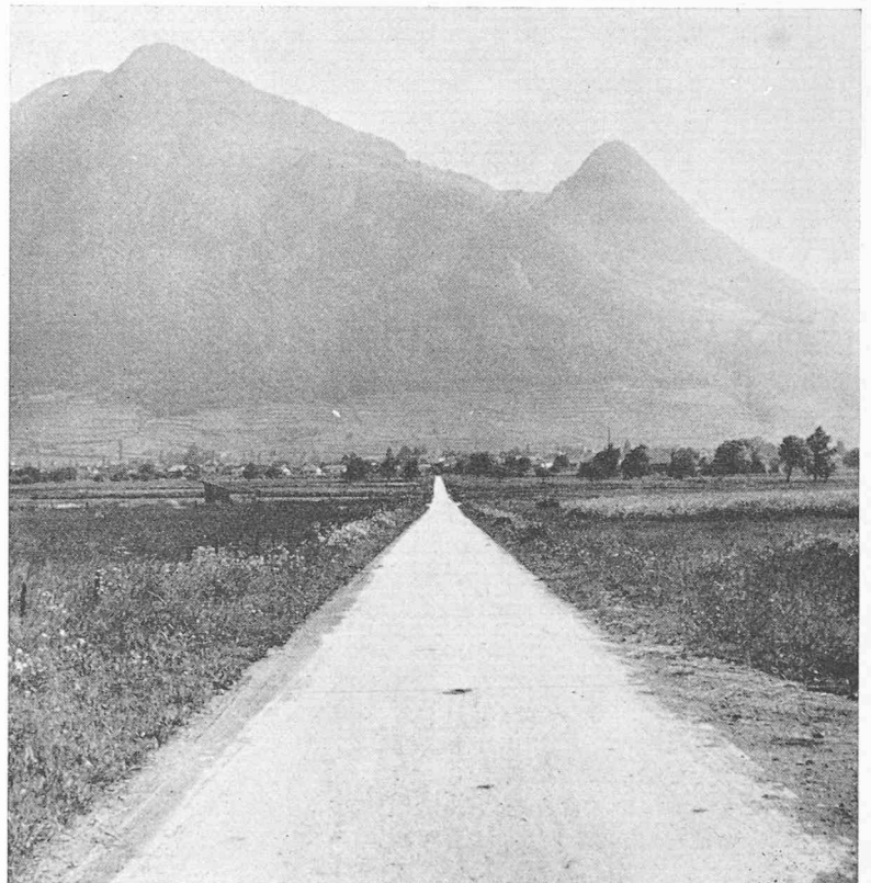
Fig. 2. — Plaine du Rhône : chaussée de béton, largeur de la dalle 2,80 m.
