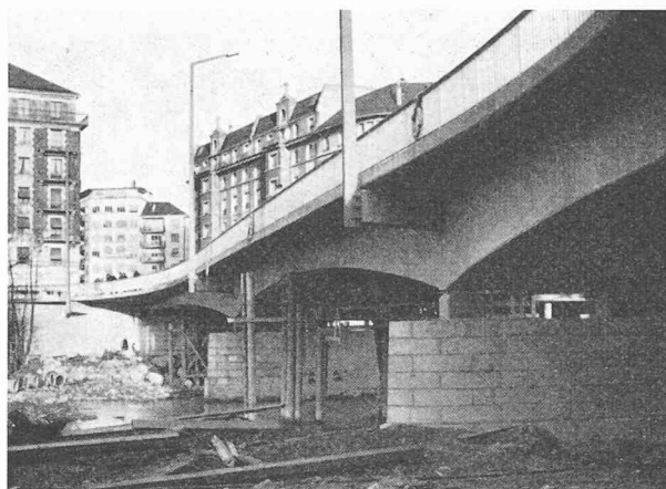
Fig. 4. — Pont sur l'Arve, à Genève (1956-1957).
