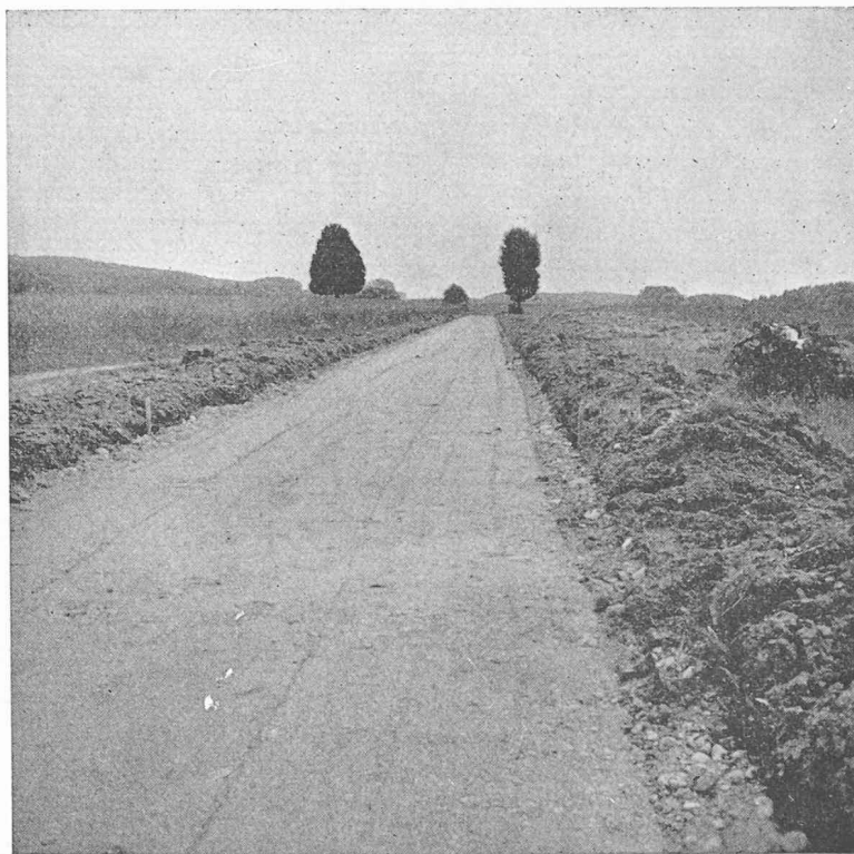
Fig. 12. — La couche de sable après roulage, prête à recevoir le béton de la dalle.
