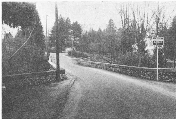
Fig. 1. — L'ancien pont vu de la rive gauche de la Drize.
