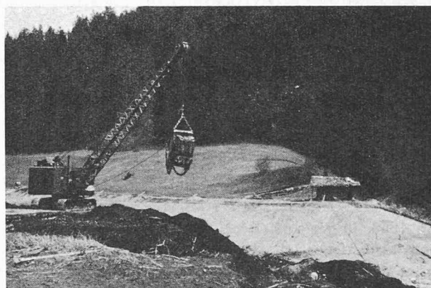
Fig. 21. — S.K.W. : Dragueline « Skoda-Menck » de 44 t sur chenille sur chaussée provisoire et matelas de madrier. Pression maximum au sol : 2,5 kg/cm 2 Pression moyenne au sol : env. 1 kg/cm 2 .
