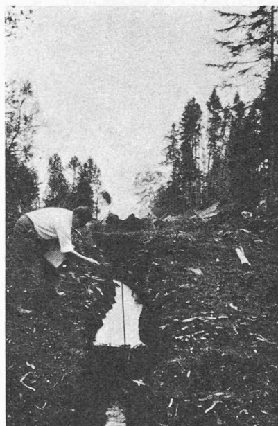
Fig. 31. — Une tranchée dans la tourbe de 2 à 2,5 m de hauteur tient verticalement.
