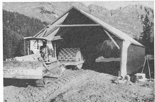
Photo n° 3. — Vue de l'aire d'essai.
