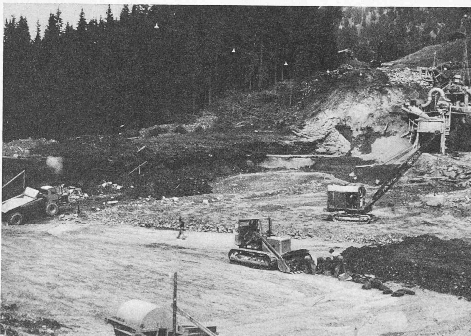
Photo n° 6. — Mise en place des terres. Au premier plan, élimination des grosses pierres. Au deuxième plan, la grue dameuse en action.
