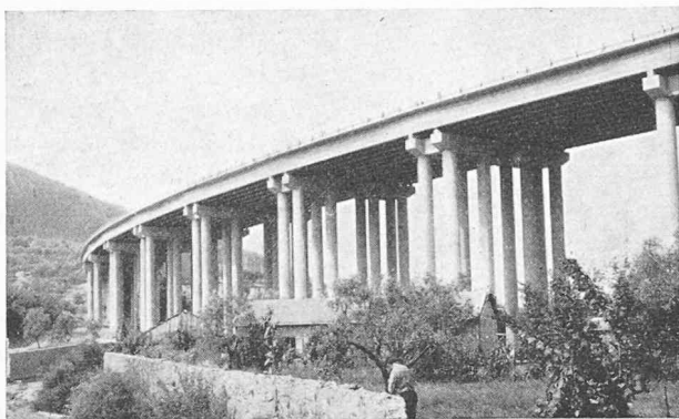
Fig. 2. — Viaduc Marinella. Quinze travées à deux appuis simples, de portée 30 m, en béton armé, construites en place sur échafaudage.
