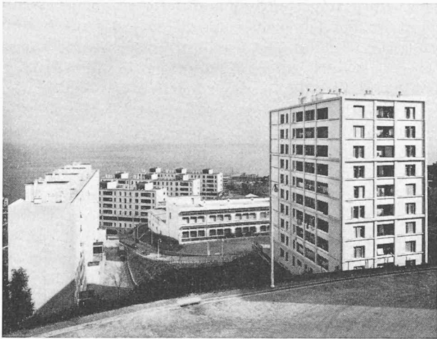
Fig. 9. — Immeubles H.L.M., à Alger (procédé Estiot).
