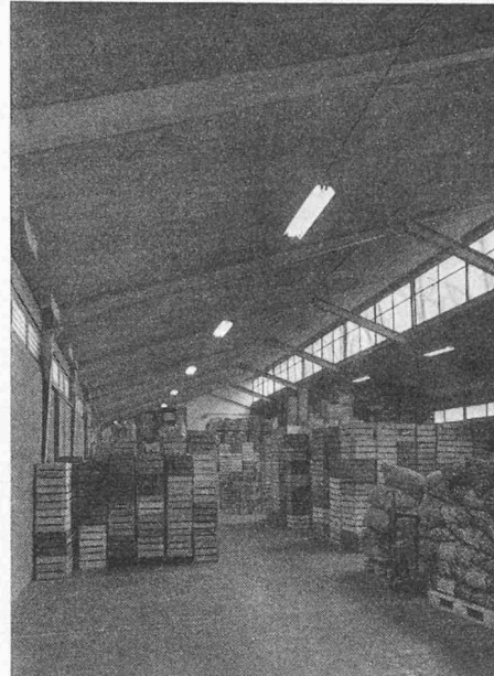
Fig. 4. — Entrepôt Migros. Vue intérieure.
