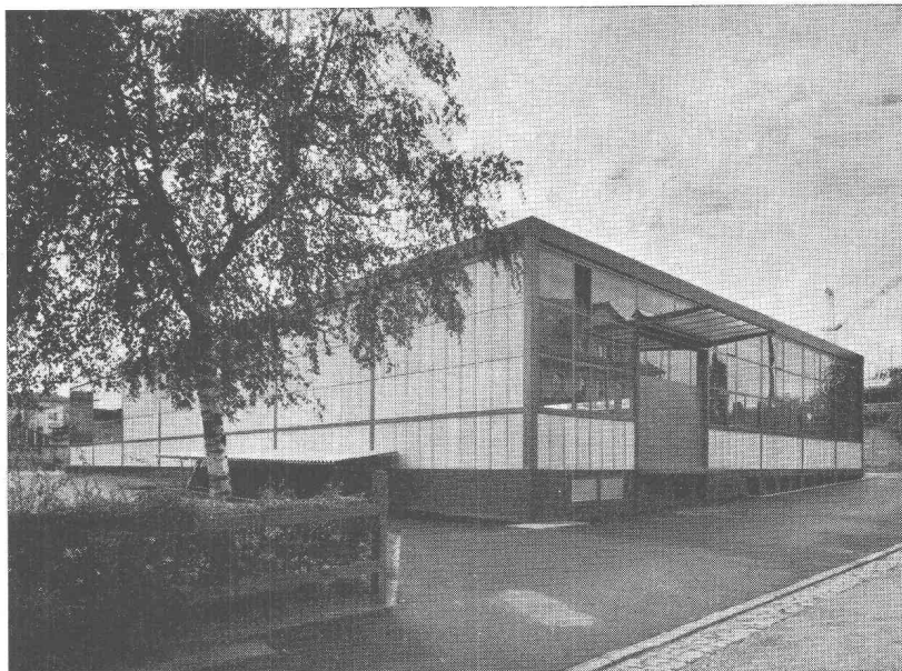
Nouvelle usine, Stauffacherstrasse 64, Berne
