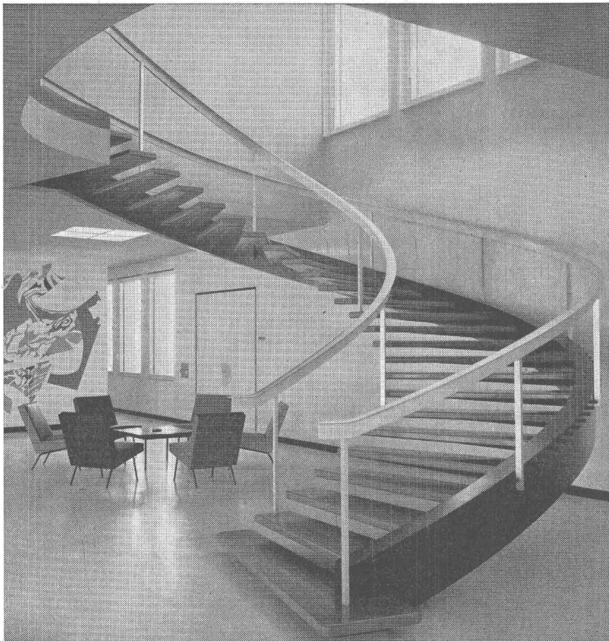
Escalier métallique avec rampe en métal léger.
