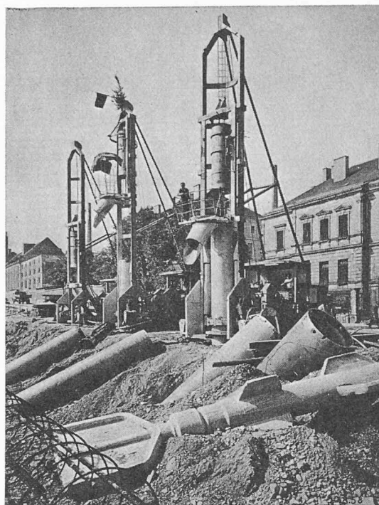
Fig. 2. — Machine Benoto « EDF 55 ».
