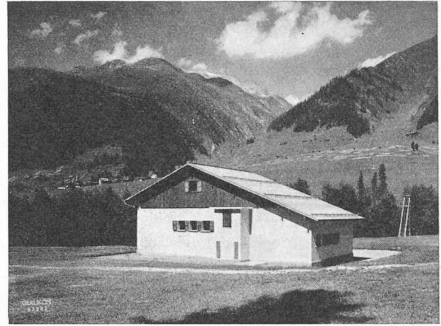
Fig. 16. — Centrale, vue d'amont.
