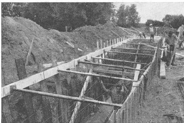
Fig. 7. — Mise en place de l'armature.
