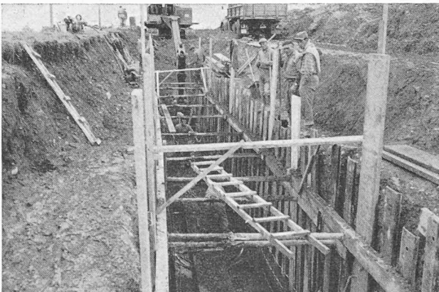
Fig. 5. — Terrassement en fouille ouverte.
