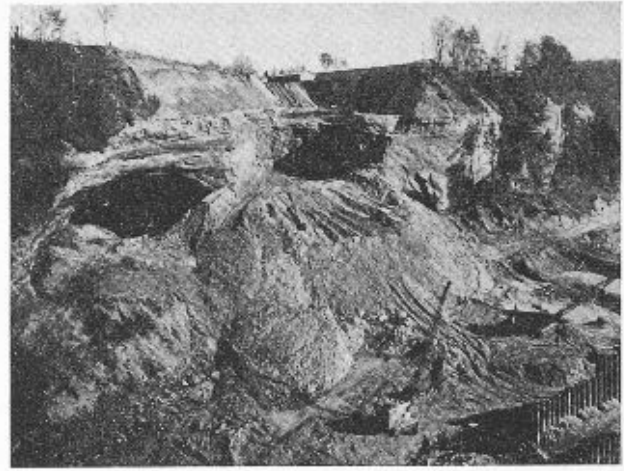
Fig. 10. — Deuxième étape. Excavation de la culée rive gauche.
