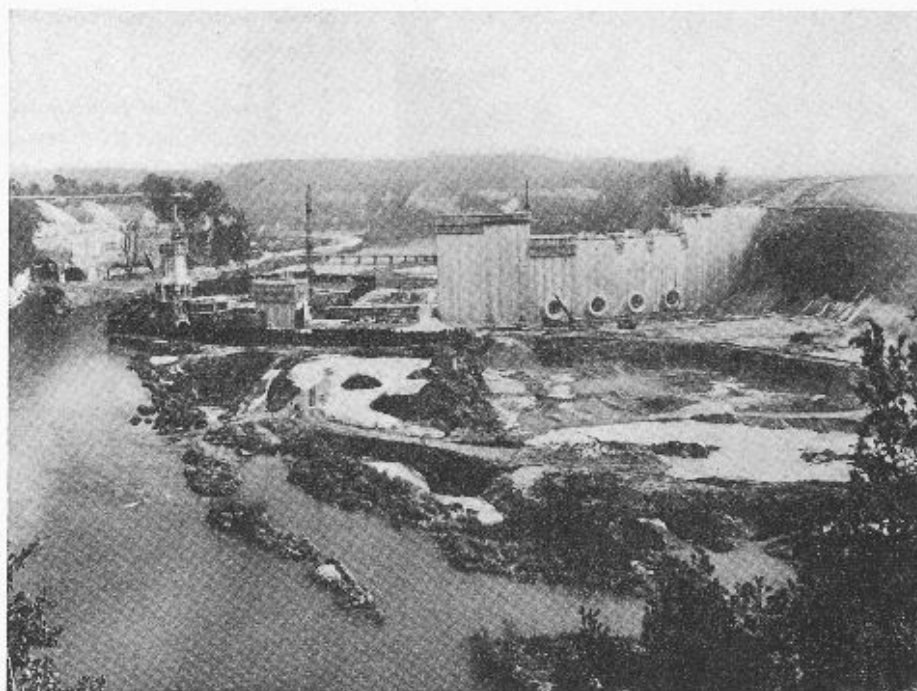
Fig. 6. — Situation des travaux, vue de l'amont, à fin 1961. (Photo Mülhauser, Fribourg.)
