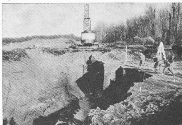
Fig. 10. — Canal du Saint-Laurent. Tranchée d'essai.
