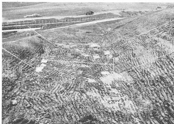
Fig. 5 et 6. — Excavation des tranchées dans la glaise bleue saturée d'eau.
