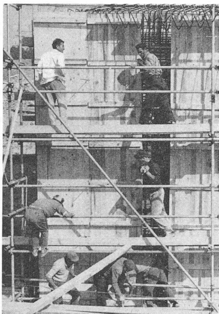
Fig. 4. — Le travail artisanal nécessaire à l'ouvrage d'art.
