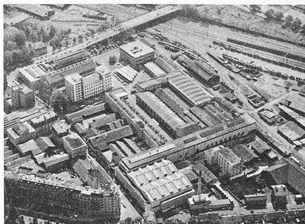
Fig. 1. — Vue d'ensemble de la S.A. des Ateliers de Sécheron.
