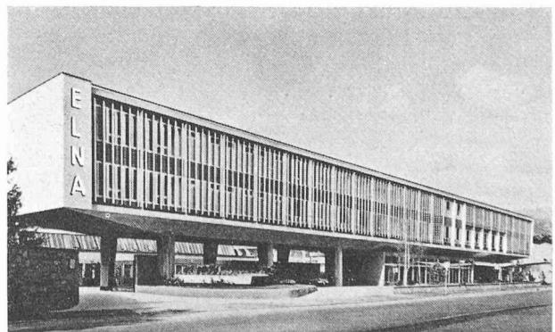
Tavaró S.A. Bâtiment administratif.
