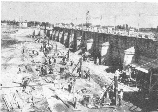
Fig. 5. — Barrage de Kerkini. Travaux de consolidation et imperméabilisation du terrain de fondation effectués en amont du barrage par la Société Fondedille.
