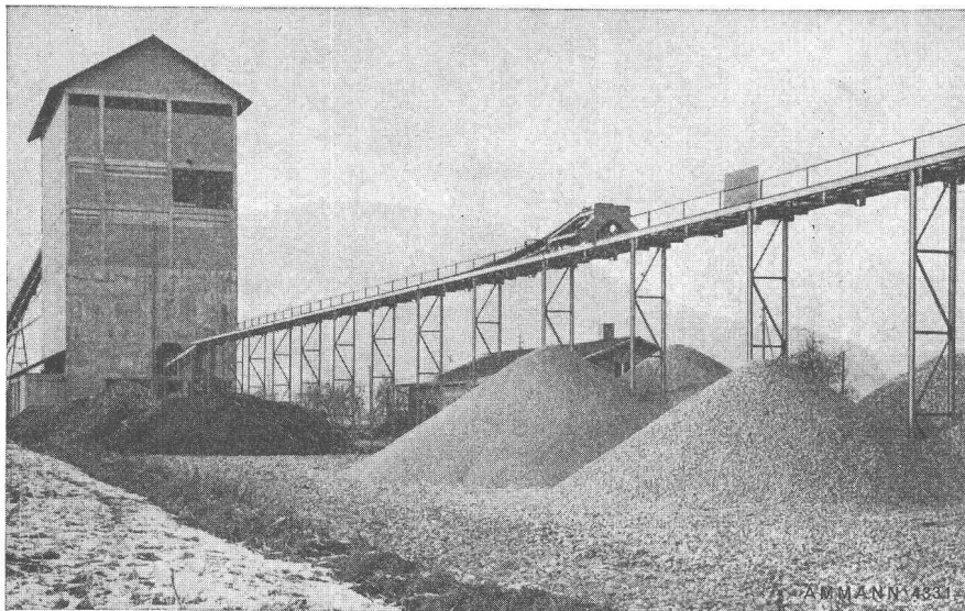
Transporteur à ruban installé dans une carrière et muni d'un chariot de déversement permettant d'entasser les différentes composantes à l'endroit voulu de part et d'autre du ruban
