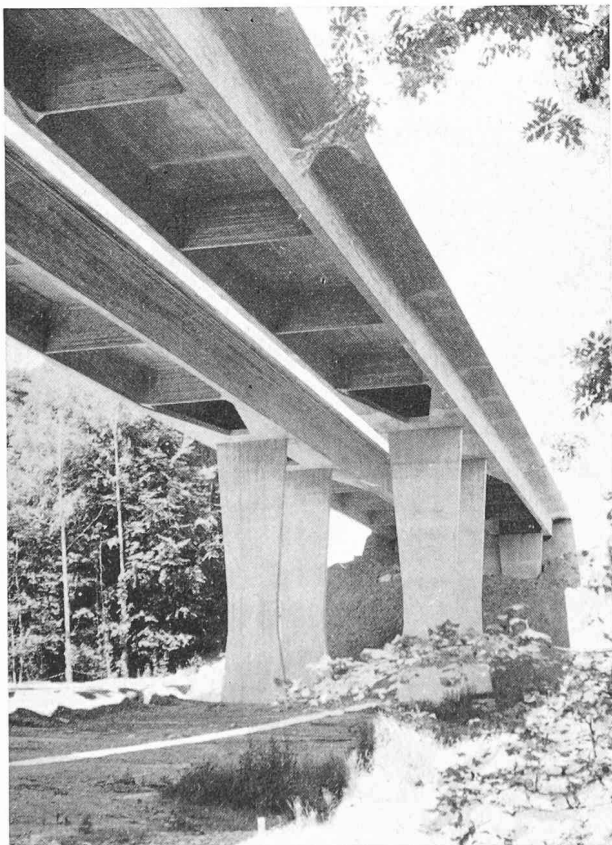
Fig. 5. — Photo d'un groupe de piles jumelées.
