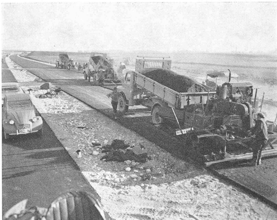
Fig. 5. — Pose de la couche de support HMT en enrobés hydrocarbonés.
