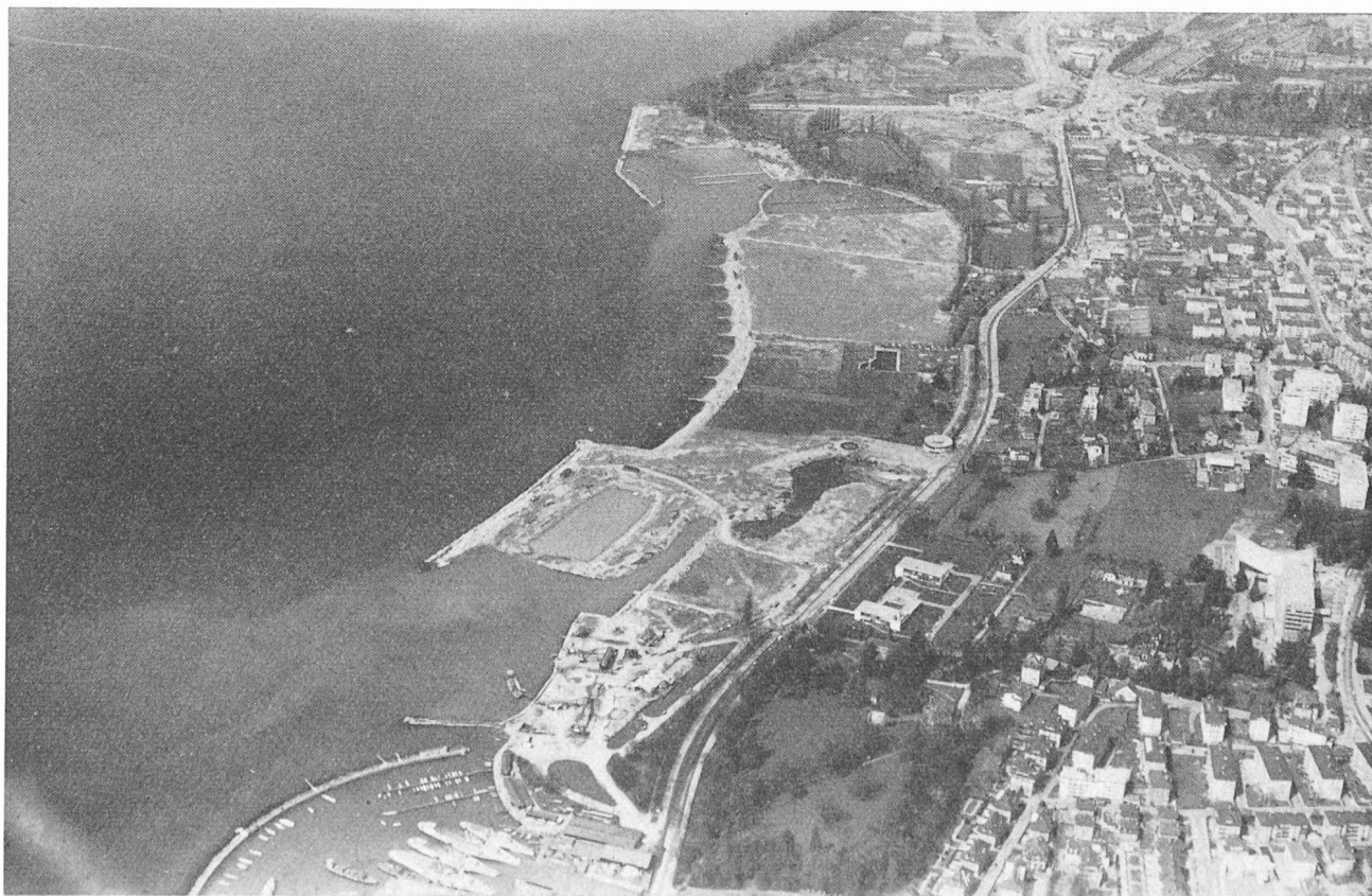
Fig. 1. — Vue aérienne des comblements des rives du lac. Etat du chantier en avril 1962.
