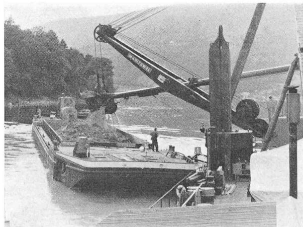
Fig. 20. — Le Manitowoc remplissant un bateau à clapet d'une capacité de 300 m 3 à l'entrée du canal de Nidau à Büren.
