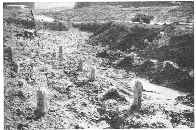
Fig. 7. — Forages dans les pieux.
