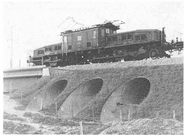
Fig. 17. — Le remblai allégé. (Photo Bureau des autoroutes)
