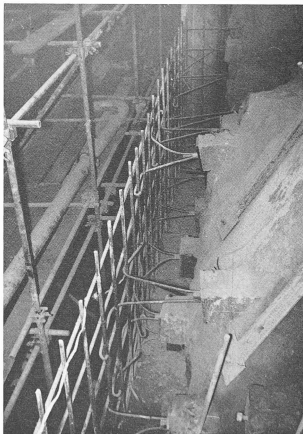
Fig. 8. — Centrale souterraine de Deanie. Vue des connexions des boulons à l'armature.
